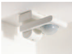
Установка детектора на потолок
